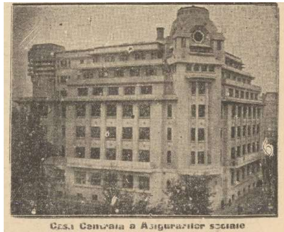
Casa Centrală Asigurărilor Sociale, Blvd. Carol colț str. Str. C. Nacu, arh. Ion Ionescu, 1940
